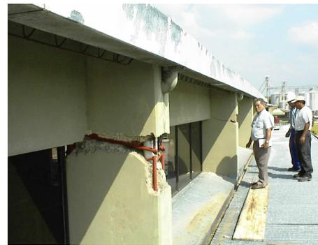
Falla en columnas.- Estructura de cubierta:  $L = 38\text{m}$   $h = 0.70\text{m}$  Fe principal:  $4 \phi 1''$  Alma  $\phi 1/2''$
